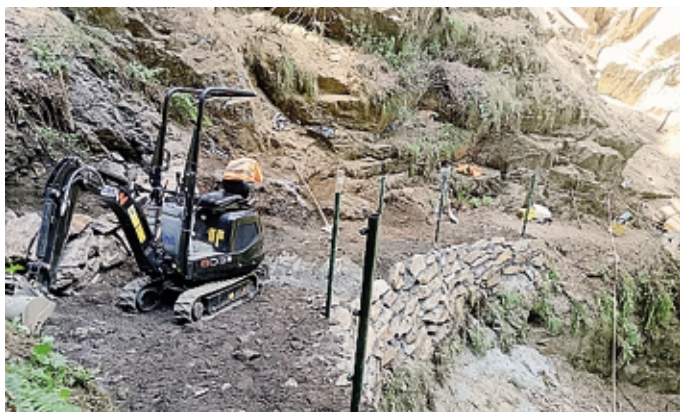
I lavori di messa in sicurezza
