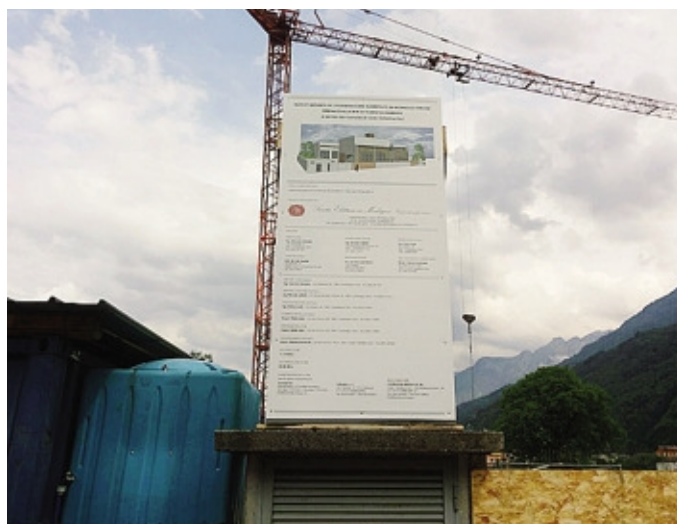
Il cantiere per la realizzazione della nuova centrale a biogas
