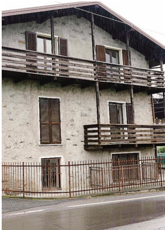
La casa di Masino che ospiterà i nuovi profughi FOTO SANDONINI
